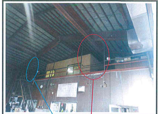
工場内 2階部分へのネット取付は 社内協議の末、作業不可でした 申し訳ございません
