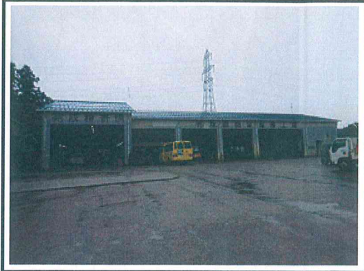
坂詰商会様 整備工場内にてハト侵入・停鳥 ファン害発生
