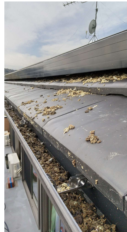
雨水溝糞清掃
