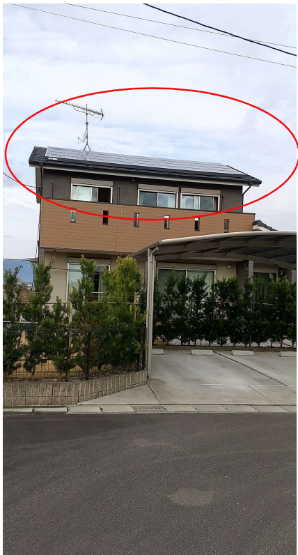
太陽光パネル
