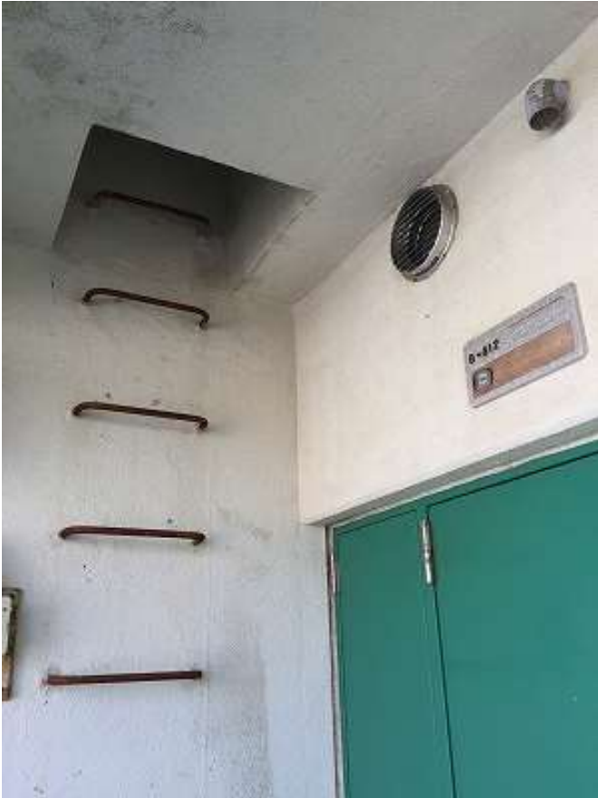
●2018. 12. 7 屋上点検口 鳩被害なし
