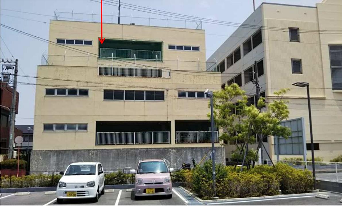
現状サッシを撤去して、開口枠にして、防鳥ネットを張
